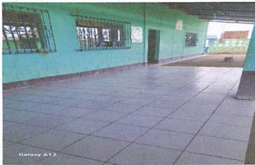
Foto 3: Colocación de piso en corredor.
