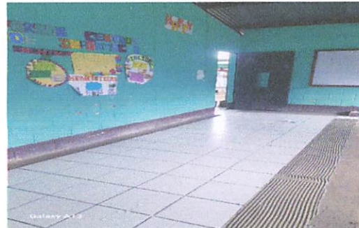
Foto 4: Colocación de piso en salón de segundo básico.
