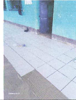
Foto 2: Colocación de piso cerámico en corredor.
