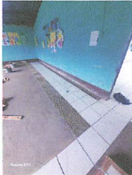
Foto 1: Colocación de piso cerámico en aula de primero básico.
