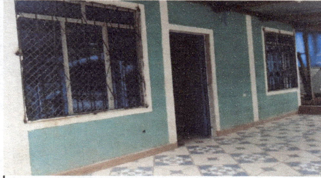
Corredor de cocina con piso ceramico y zocalo, 3 ventanas de aluminio con sus vidrios, puerta de cocina de metal nueva de color azul.
