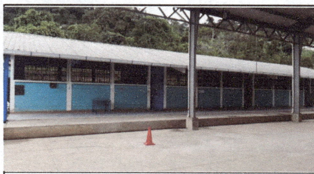
Canales nuevas y colocadas en todo el corredor de aulas y direccion, fabricacion de 8 protectores de lampara en cancha polideportiva y piso torta de cemento entre el corredor de aulas y cancha.
