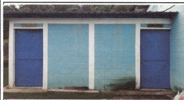
Reparado las puertas, chapas nuevas yale y pintadas, ya en uso.
