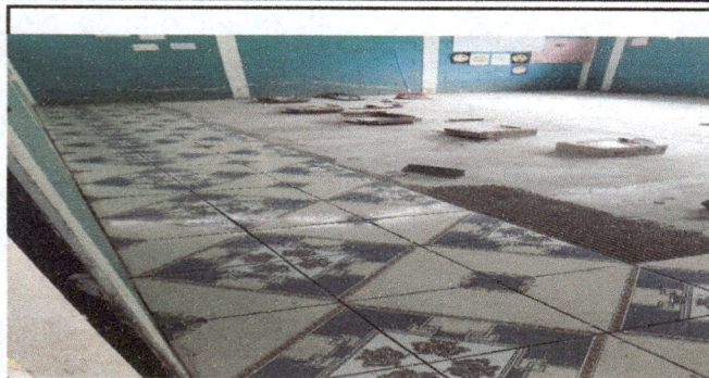
Colocacion de piso dentro de las 3 aulas y direccion.
