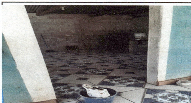
Colocacion de piso dentro y corredor de cocina, colocacion de zocalo entro y corredor de cocina.
