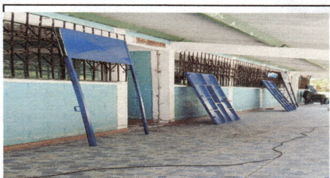
Colocacion de puertas de color azul de 3 aulas, direccion y cocina, reparacion y colocacion de 2 puertas de baños
