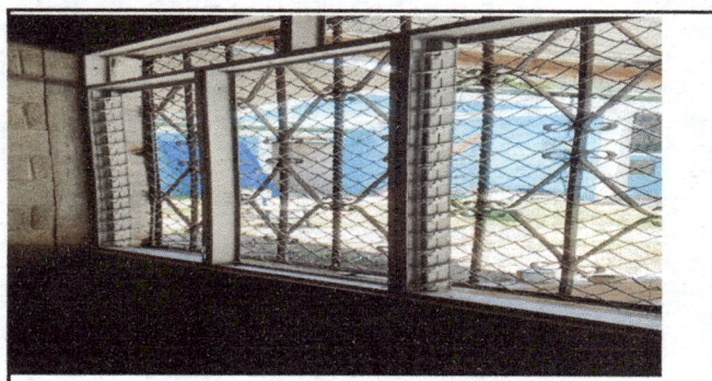
Colocacion de 3 ventanas en cocina.
