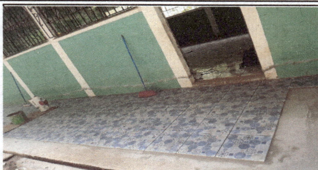
Colocacion de piso en todo el corredor de las aulas y direccion.
