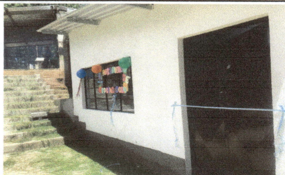
Foto 5: fase final del 100 de remozamiento de cocina
