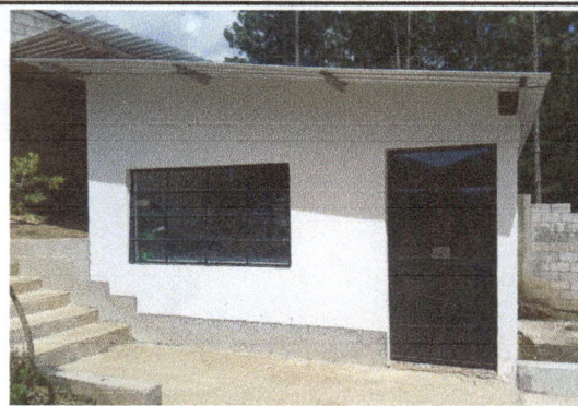
Foto 2: Vista frontal terminada
