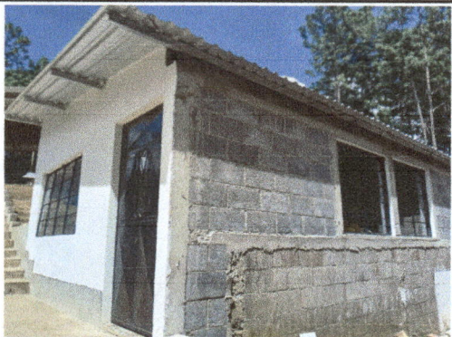
Foto1: Finalización de la cocina
