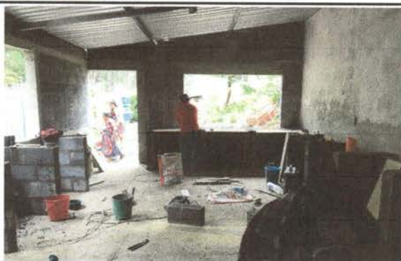
Foto 3: vista interior con avance de 80%
