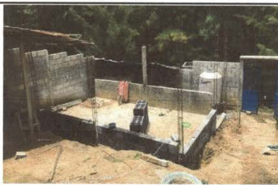
Foto 6: Vista lateral de construcción
