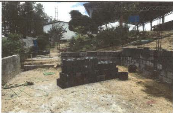
Foto1: inicio del remozamiento de cocina
