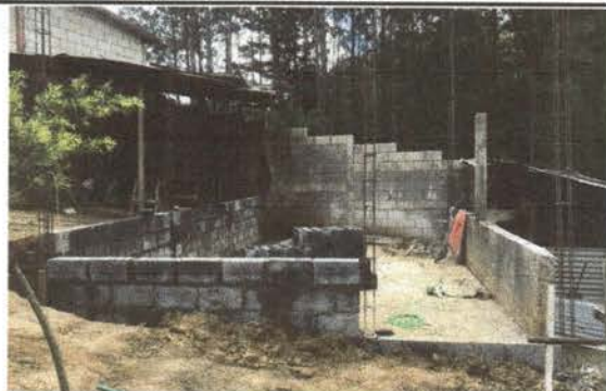
Foto 5: Inicio frontal de la cocina
