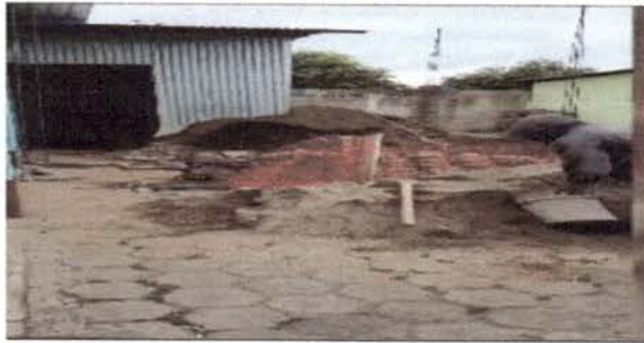
Foto1: Inicio de zanqueo de ampliación de cocina EOUM 'Rafael Alvarez Ovalle JV'
