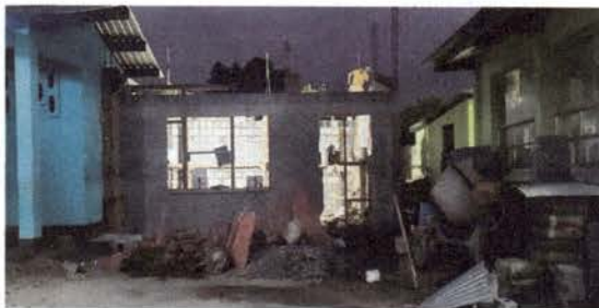
Foto 5: Inicio de armado de techado.
