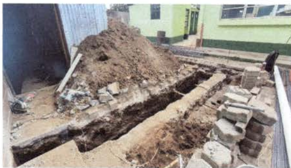
Foto 3: Base solida de construcción.
