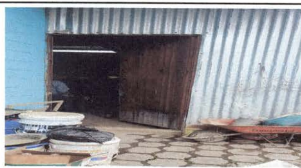
Foto 4: Desarmado de cocina antigua.
