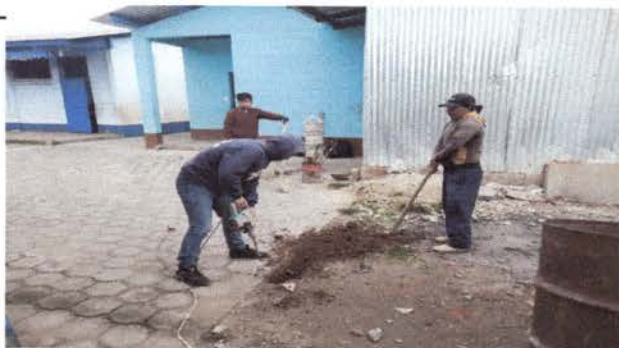
Foto 5: Inicio de trabajos de cocina, levantado de adoquines en el área de cocina.
