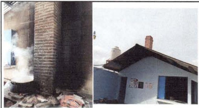
Foto 9: Construcción de chimenea de ladrillo en cocina del establecimiento.
