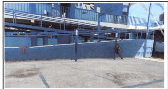
Foto 10: Levantamiento de pared de block debajo de la rampa del edificio del ala oeste.
