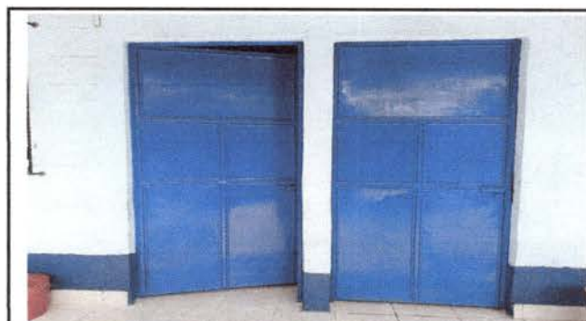
Foto 6: Mantenimiento a estructura de puertas de metal
