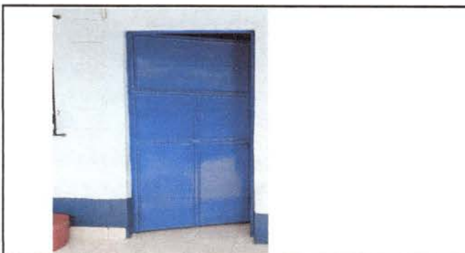
Foto 5: Sustitución de chapa de puerta de metal
