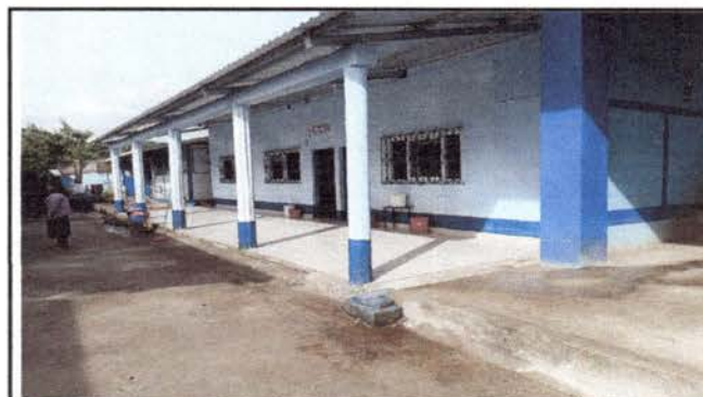
Foto 4: Sustitución de estructura de soporte de madera por metal y cambio de lámina por lámina troquelada de alucinc
