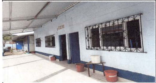
Foto 8: Colocación de balcones de metal para ventanas
