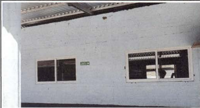
Foto 7: Cambio de ventanas de metal por ventanas de PVC con ventilación
