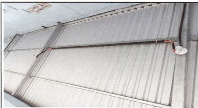
Foto 3: Reparación de cableado eléctrico en salones de clases
