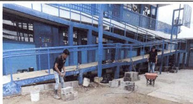
Foto 12: Levantamiento de pared debajo de rampa del edificio en el ala oeste.
