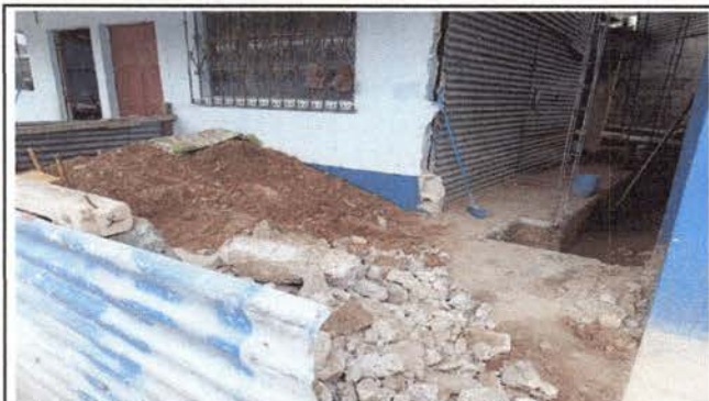
Foto 1: fundición de columnas para el levantamiento de pared
