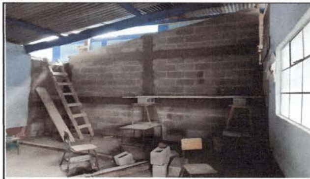
Foto 2: levantamiento de pared para la completación de salón de clases.
