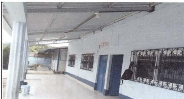
Foto 11: Colocación de balcones para ventanas.
