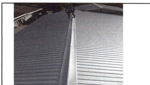
Foto 6: Cambio de lámina por lámina troquelada de Aluzinc
