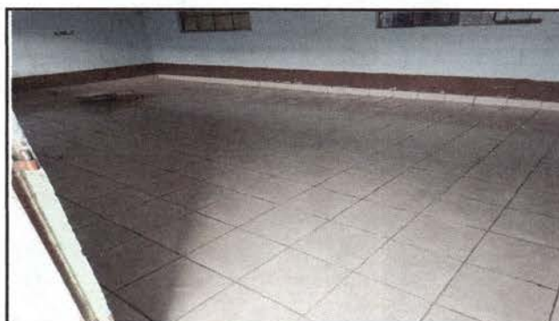
Foto 4: Colocación de piso cerámico en salones de clases y pasillos.
