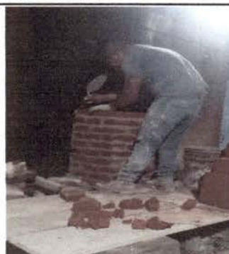
Foto 8: construcción de chimenea de ladrillo para cocina.
