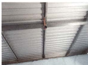
Foto 9: reparación de cableado eléctrico en salones de clases.
