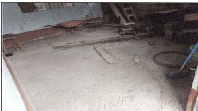
Foto 3: Nivelación de piso previo a la colocación de piso cerámico.
