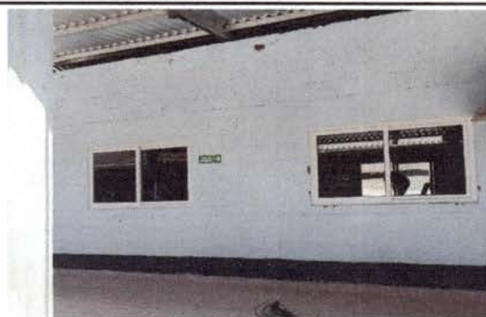
Foto 10: cambio de ventanas de metal por ventanas de PVC con ventilación
