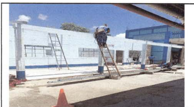
Foto 5: sustitución de soportes de madera por soportes de metal para techado
