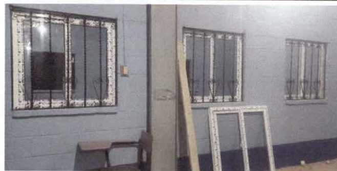
Foto 6: Balcones y ventanas culminados.
