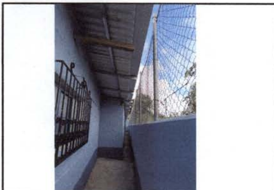
Foto 9: Colocación de canales.
