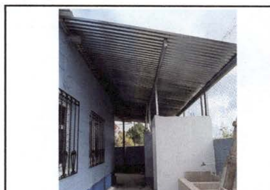
Foto 12: Sustitución de lámina en área de sanitarios.
