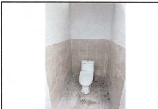
Foto 7: Sustitución de la loza sanitaria
