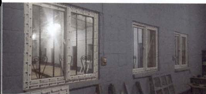
Foto 5: Colocado de ventanas de pvc
