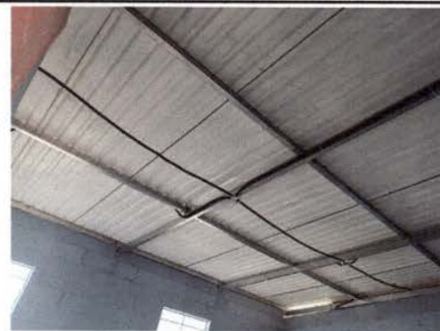
Foto 2: Colocación del alumbrado en estructura de metal y lámina.
