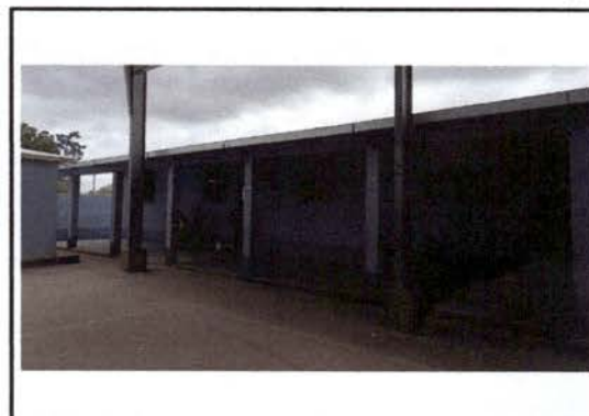
Foto 10: Colocación de canales y bajadas de agua.
