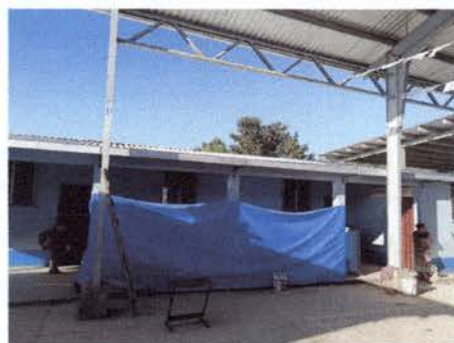
Foto 10: Proceso de colocación de canales y bajadas de agua
