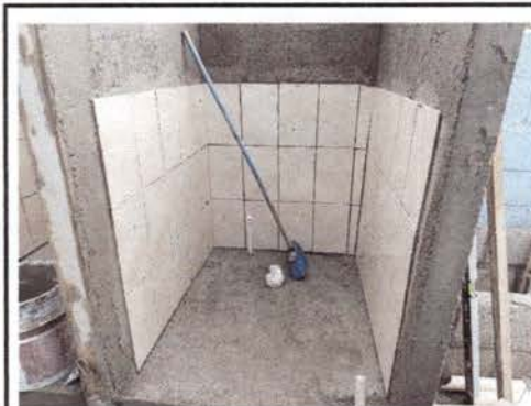
Foto 8: Sustitución de piso cerámico y azulejo en las paredes
