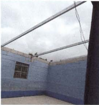
Foto 1: Colocado de block y estructura de metal.
