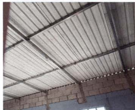
Foto 2: Levantamiento de block, estructura de metal y lámina.
