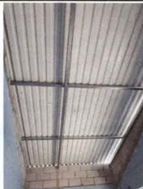
Foto 3: Levantamiento de block en paredes, para evitar la humedad y colocado de estructura de metal.
