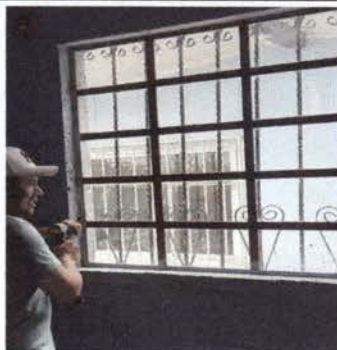
Foto 5: Comienzo de la colocación de las ventanas.
