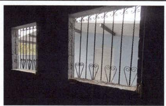
Foto 6: Retoque de pintura a los balcones de metal
