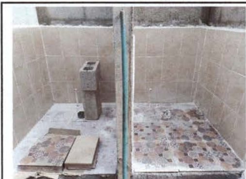
Foto 7: Sustitución de la loza sanitaria
