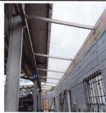
Foto 4: Colocado de filas de block en las paredes, para mejorar la ventilación
