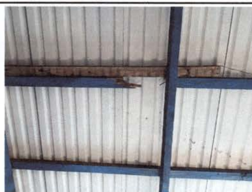
Foto 2: Quebradura de las vigas de madera y remiendos a la estructura.
