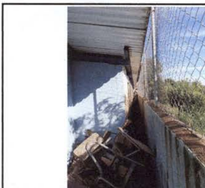
Foto 9: Deterioro de paredes y filtración de agua por falta de canales.
