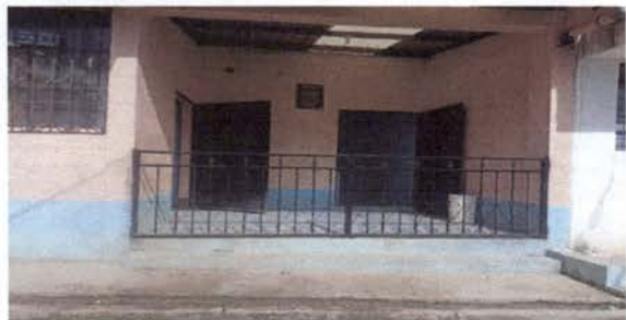
Foto 1: trabajo finalizado de las barandas
