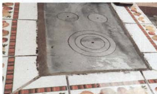
Foto 2: trabajo finalizado de plancha
