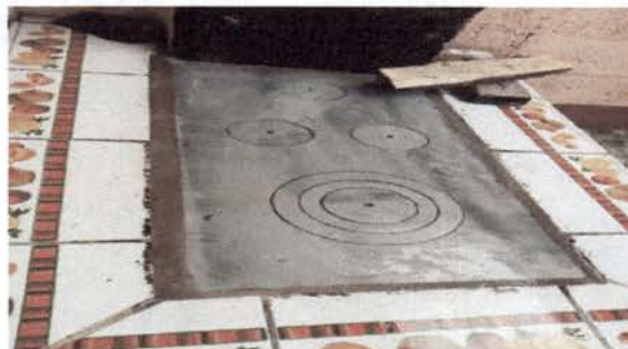
Foto 2: ya esta sustituido la plancha falta que la utiliza
