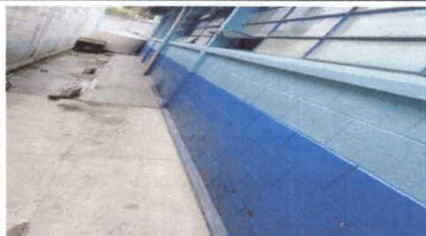
Foto 4: esta en proceso la torta de concreto alrededor de las aulas
