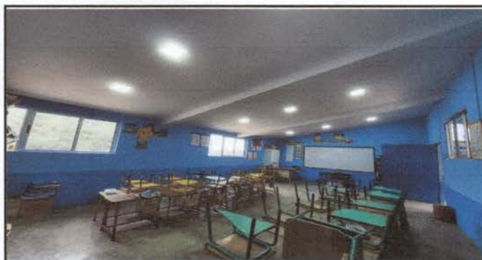
Foto 3: Finalización cambio de techado y mejoramiento de iluminación en el salón de segundo primaria.
