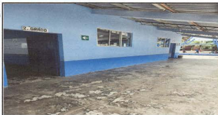
Foto 5: Finalización de cambio de ventanas a ventanas movedizas
