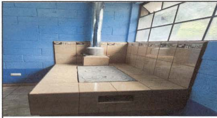
Foto 2: Finalización de remodelación de pollo para cocinar refacción
