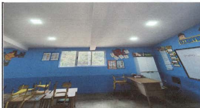
Foto 4: Finalización cambio de techado y mejoramiento de iluminación en el salón de primero primaria
