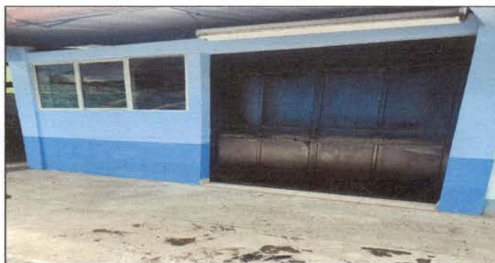
Foto 6: Finalización de cambio de ventanas y puertas.
