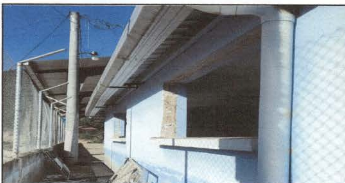
Foto 5: Remozamiento de ventanas
