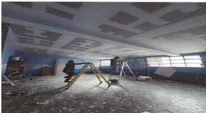
Foto 3: Remozamiento de salón de clases del grado de segundo primaria
