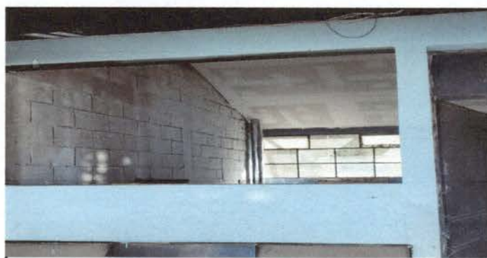
Foto 6: Remozamiento de Puerta y ventanales
