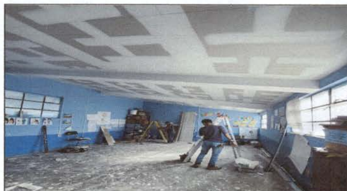
Foto 4: Remozamiento de Salón de clases del grado de primero primaria
