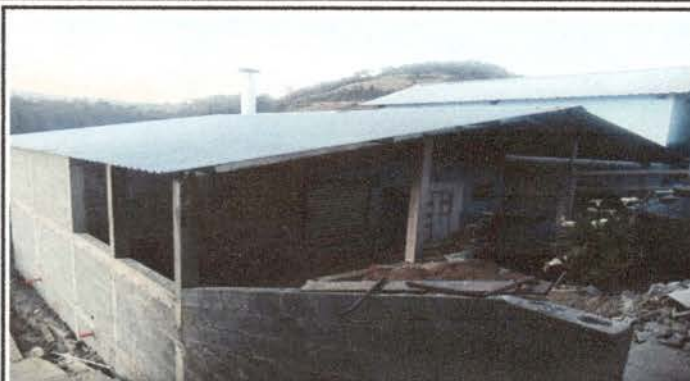
Foto1: Culminación de paredes y techo
