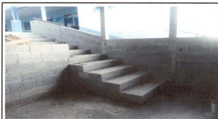
Foto 4: Levantado de paredes y gradas
