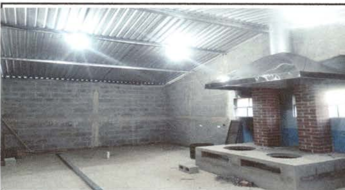
Foto 3: Polletones y ampliación de cocina
