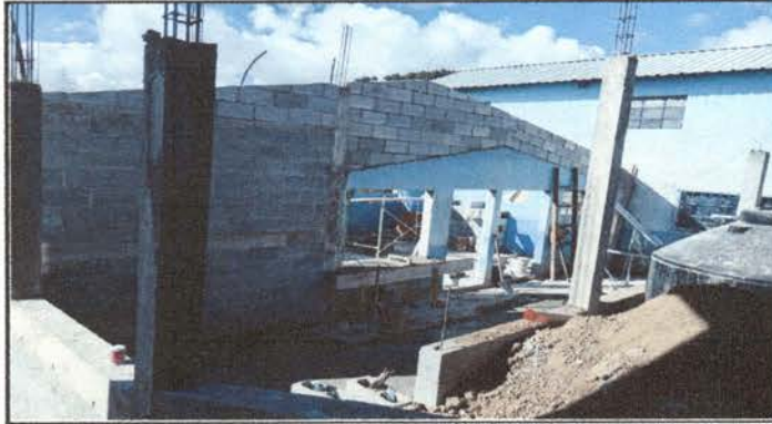
Foto 1: Levantado de pared
