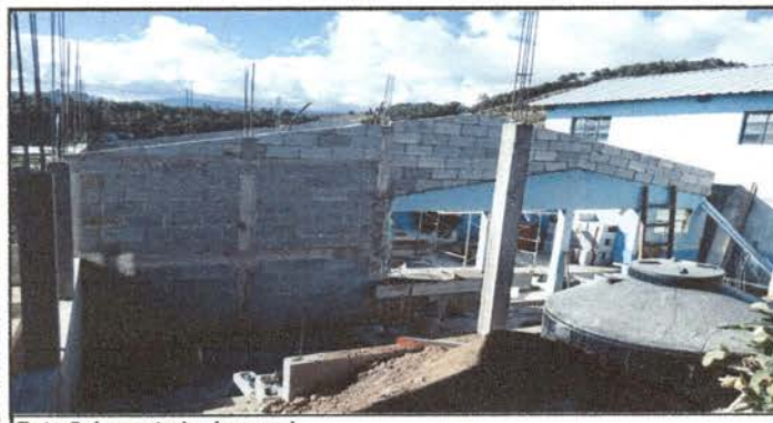
Foto 5: Levantado de pared
