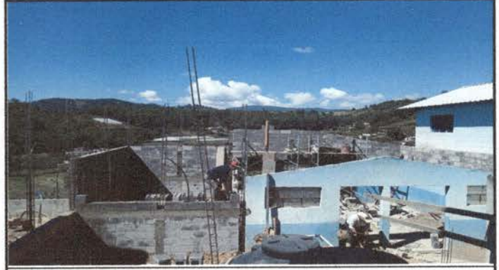
Foto 2: levantado de pared
