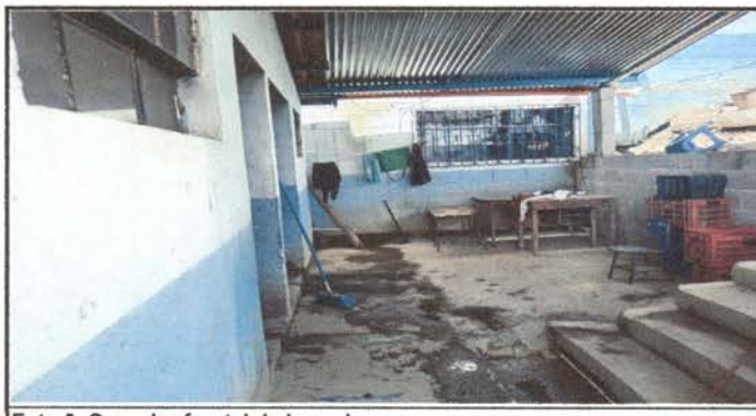
Foto 5: Corredor frontal de la cocina.
