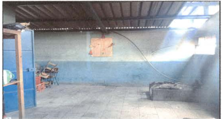
Foto 4: Espacio de la cocina donde se necesita ampliación y ventanal.
