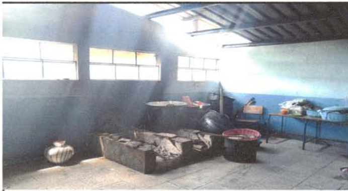
Foto 3: Dos polletones ya deteriorados.
