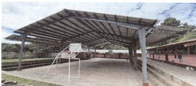
Foto 3: vista del actual del techado para que nuestros alumnos esten en sombra al momento de llevar a cabo actividades
