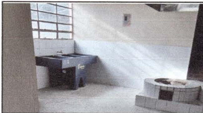
Foto 4: Vista actual del interior de la cocina y su pila
