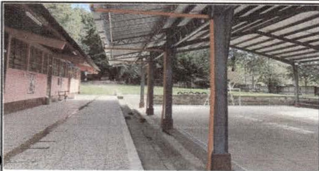
Foto1: ajuste del techado, acabado final de una ala
