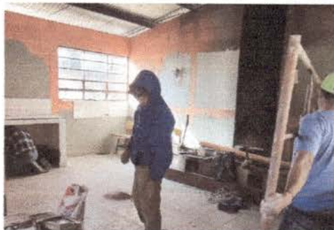
Foto 5: Trabajadores en plena ejecucion del remozamiento de la cocina
