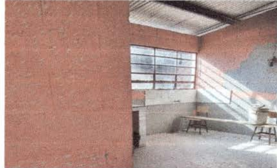
Foto 6: Picada de pares para el repello.
