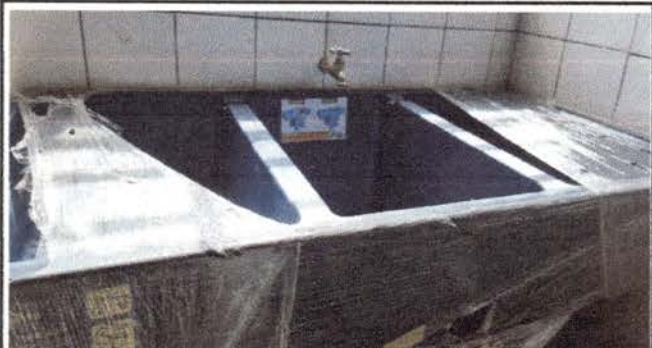
Foto 4: Vista de la pila nueva que se esta instalando
