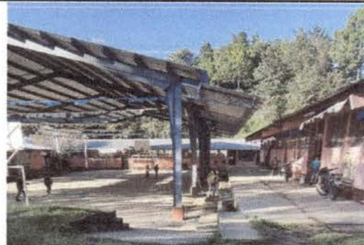
Foto 2: vista del polideportivo y el avance de los trabajos de remozamiento,
