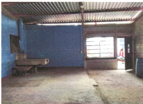
Foto1: culminación de paredes y techado
