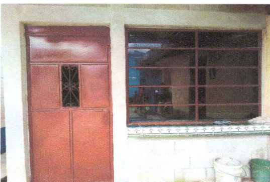
Foto 3: colocación de puerta y distribuidor de alimentos
