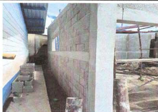
Foto 3: Levantado de muro
