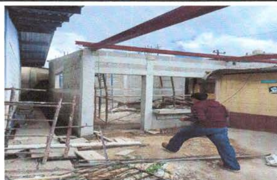
Foto 4: falta azulejo en el distribuidor de alimentos
