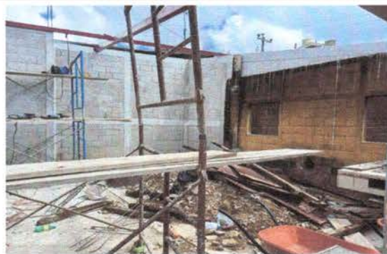
Foto 2: Colocacion de estructura metalica
