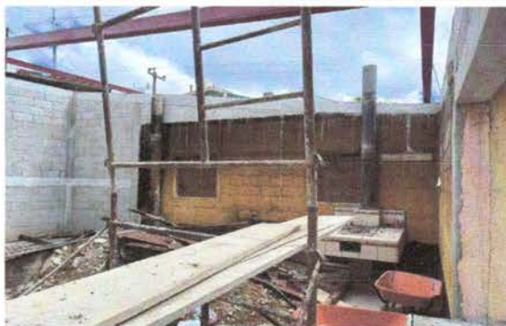
Foto1: Ampliacion de cocina
