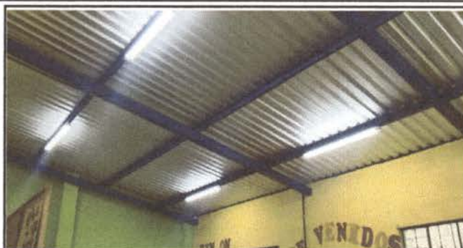
Foto 14. colocacion de lámparas en aulas.
