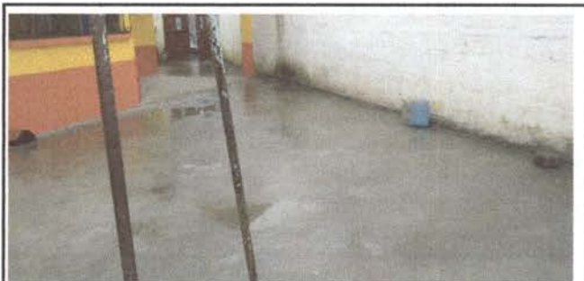
Foto 18: finalización de torta de losa de patio.
