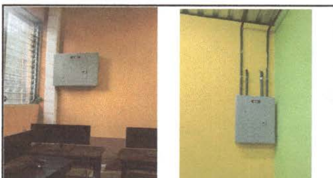
Foto 16: colocación de caja de plifones de centro de computo y caja de filpones de distribución.
