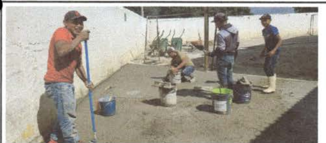
Foto 17: Colocación de concreto para losa de patio.
