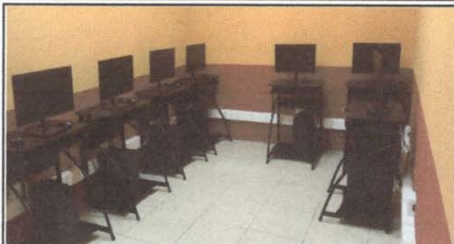
Foto 13 : Finalización de sistema eléctrico de centro de computo.
