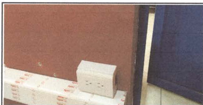
Foto 6: colocacion de cajas de tomacorrientes de centro de cómputo.
