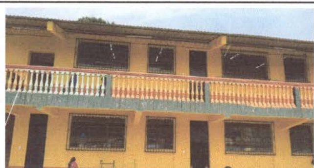
Foto 8 Pintura de exrterior de aulas de planta alta y baja de la escuela.
