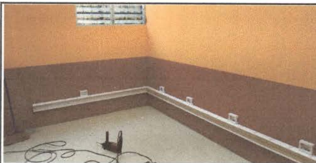
Foto 5: Cambio de sistema eléctrico de centro de computación.
