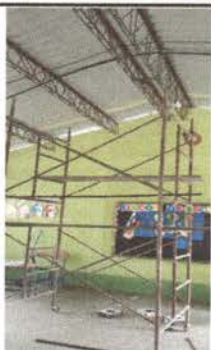
Foto 1: Cambio de sistema eléctrico de planta alta de establecimiento.
