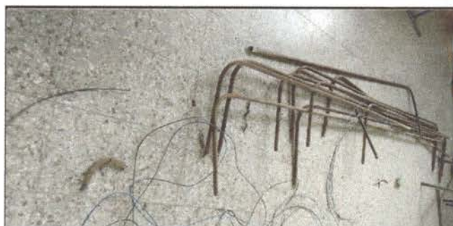
Foto 4: cambio de tubos de metal de iluminación de aulas de planta alta.
