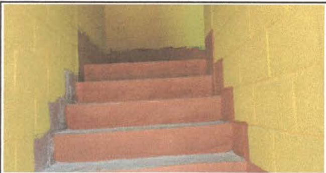
Foto 9: Pintura de exterior de pasillo y gradas planta alta de aulas.
