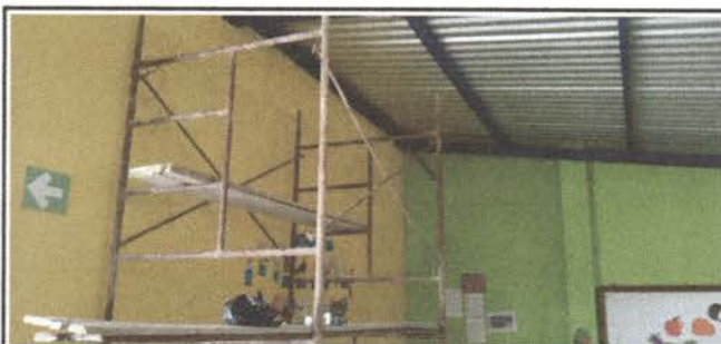
Foto 3: Cambio de sistema eléctrico de aula y dirección.
