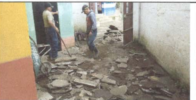
Foto 11: Levantado de torta de patio.
