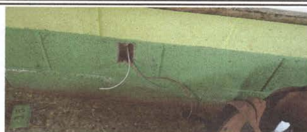
Foto 2: Cambio de cable de tomacorrientes de aulas planta alta, planta baja de aulas.
