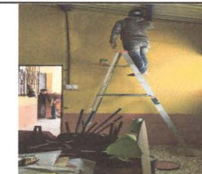
Foto 10: Pintura de interior de Dirección.
