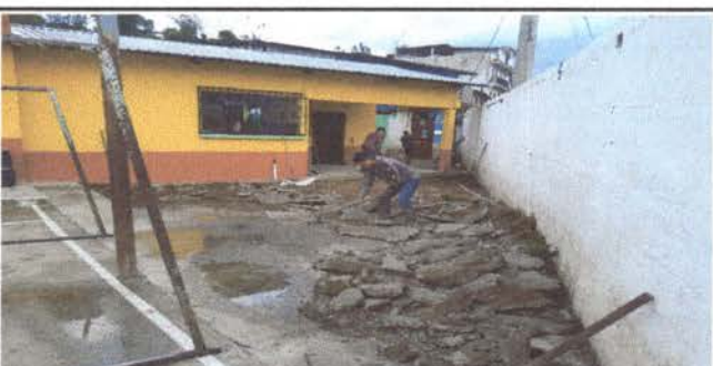
Foto 12: Levantado y nivelacion de torta de patio.
