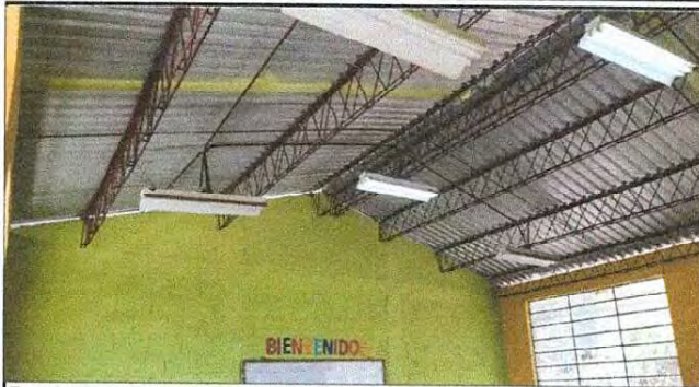
Foto 1: Cambio de lámparas de aulas, planta alta, cableado y sistema eléctrico.
