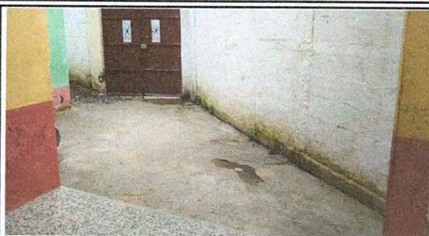
Foto 14: Reparación de torta de patio de la entrada de la escuela
