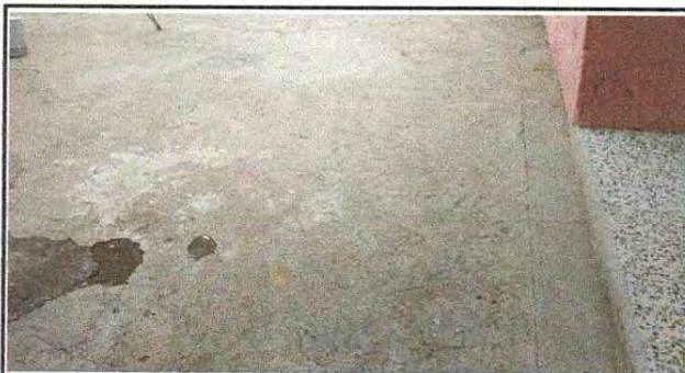
Foto 16: total de reparación de torta de patio 85 metros cuadrados.
