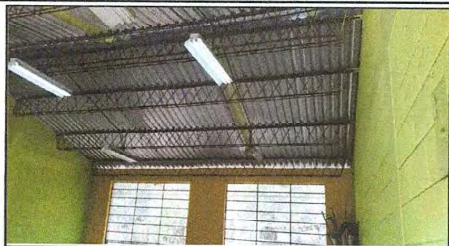
Foto 2: Cambio de lámparas planta baja, cableado y sistema eléctrico
