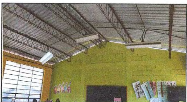
Foto 4: Cambio de sistema eléctrico de aulas. (cable, candelas, base de candelas, apagadores, tomacorrientes,)
