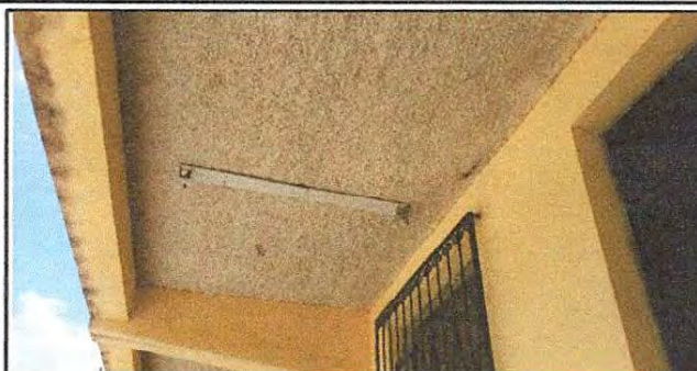
Foto 8: Pintura para las paredes de las aulas de la escuela.
