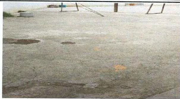
Foto 13: Reparación de pavimento de patio de la escuela.
