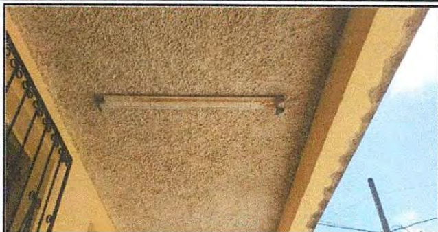
Foto 7: cambio de sistema electrico de corredor de escuela de planta baja lamparas, tomacorrientes, apagadores
