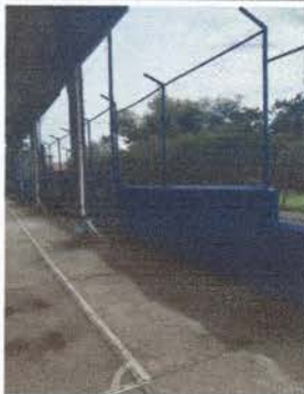
Foto 5: MANTENIMIENTO DE MURO PERIMETRAL CON IMPERMEABILIZANTE DE PARED VERTICAL.
