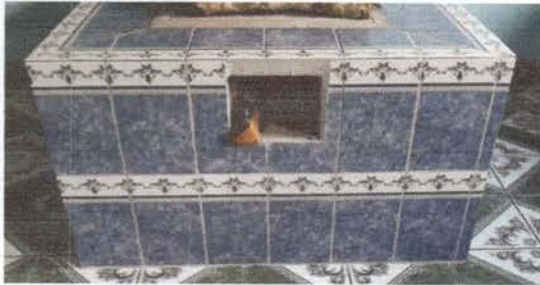
Foto 1: Reparación de Poyeton, previo/durante/posterior
