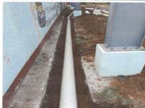
Foto 6: SE NECESITA INSTALAR LINEA DE DRENAJE PARA LAS BAJADAS DE AGUA DE LA CANCHA POLIDEPORTIVA.
