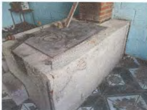
Foto 1: Reparación de Poyeton, previo/durante/posterior
