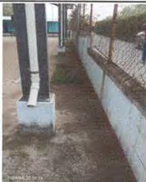
Foto 5: MANTENIMIENTO DE MURO PERIMETRAL CON IMPERMEABILIZANTE DE PARED VERTICAL.
