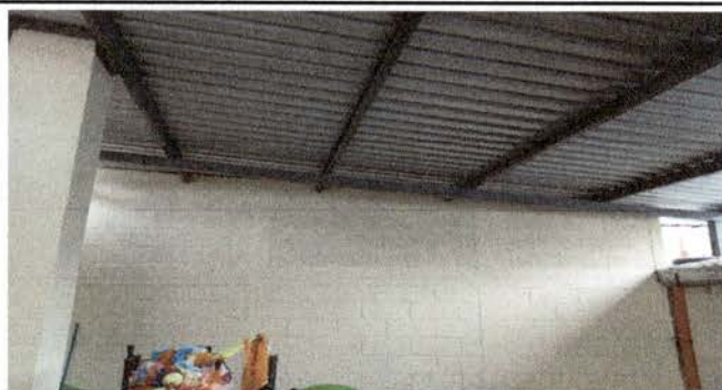
Foto 6: levantado de pared block
