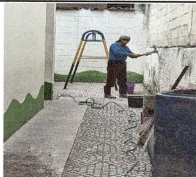
Foto 2: filtraión, piso en patio
