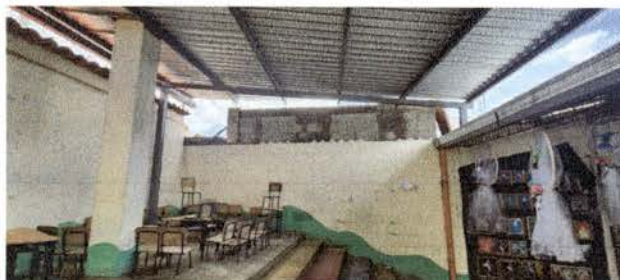
Foto 6: levantado de pared block
