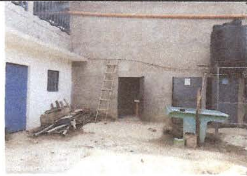
Foto 4: SE NECESITA AMPLIAR S.S. CON ESTRUCTURA DE METAL Y TECHO DE LAMINA TROQUELADA CALIBRE 26
