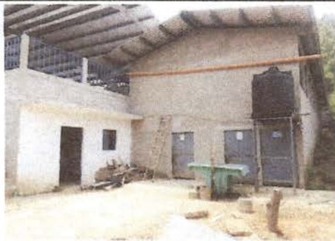
Foto 3: CAMBIAR DE LUGAR BASE PARA TINACO. PARA LA AMPLIACION DE S.S.
