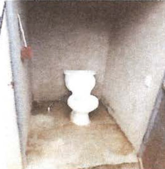
Foto 2: INODORO CON FUGAS, CAMBIO A INODORO TIPO PUSH, INSTALACION DE PISO CERAMICA ANTIDESLIZANTE.
