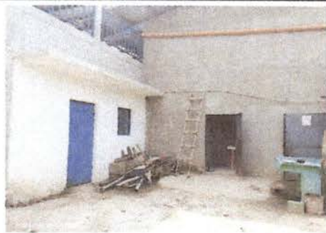
Foto 5: AMPLIACION CON LEVANTADO DE MURO BLOCK.
