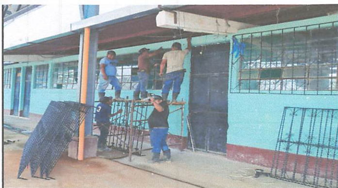
Foto 3: Colocación de balcones, durante
