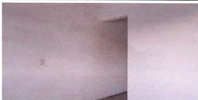
Terminado de la cocina.
