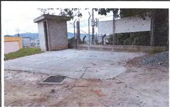
Terminado de pavimento para taller de mecánica.
