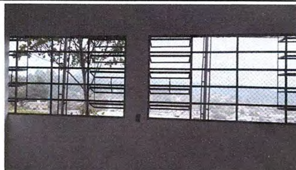
Terminado en colocación de vidrios para la cocina.
