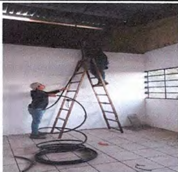
Cambio de techo y conexión de energía eléctrica.
