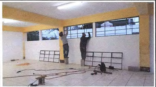
Repello y colocación de vidrios en salón de usos múltiples.
