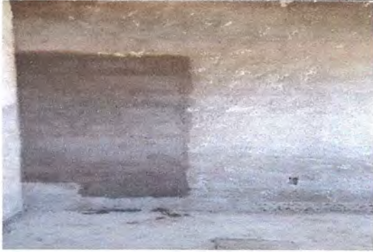
Picado de pared para repellar de la cocina.
