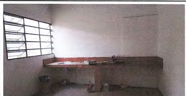
Colocación de vidrios y lavatrastos.
