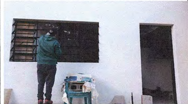
Colocación de vidrios y puertas.
