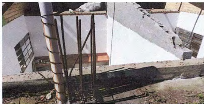
Techo de cocina.
