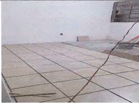
Instalación de piso de la cocina
