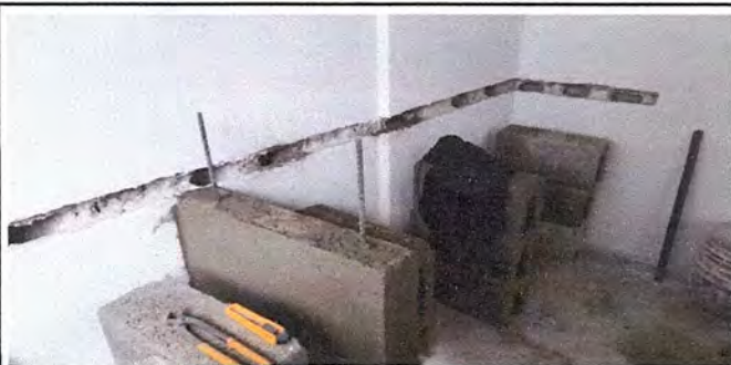
Colación de lavatrastos en cocina.
