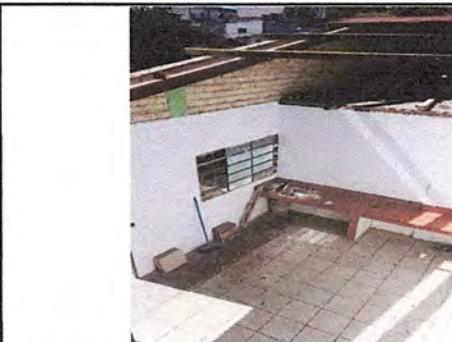
Colocación de techo de cocina.
