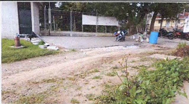
pavimentación para taller de mecánica.
