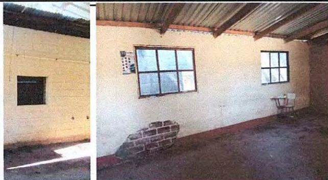
Foto 7: sustitucion de ventana de madera mas vidrio.
