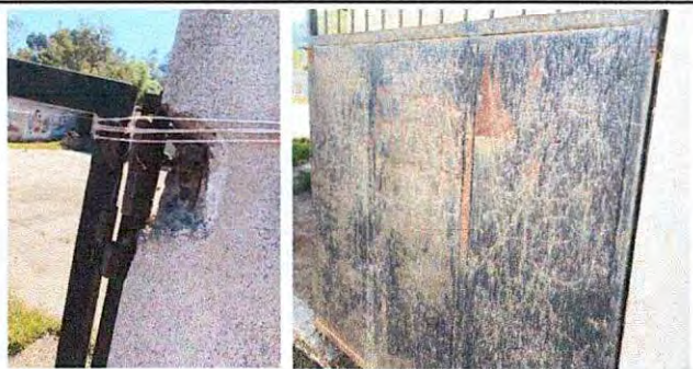
Foto 5: sustitución de porton de metal
