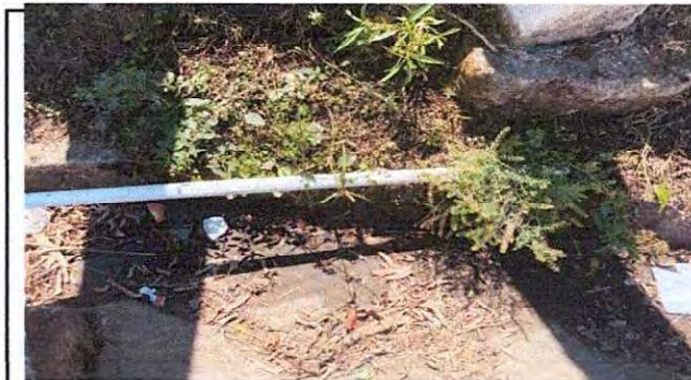
Foto 12: Sustitución de tubería lineal principal
