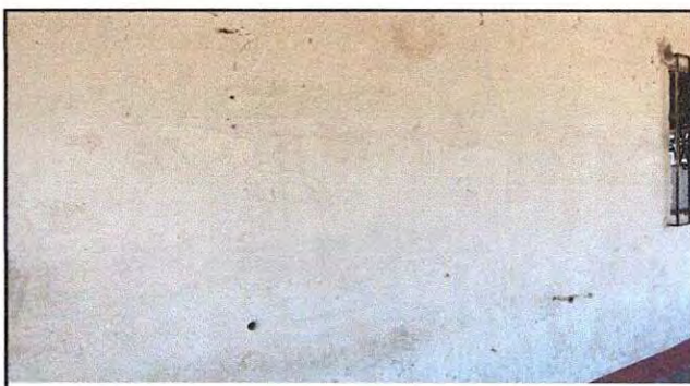
Foto 10: Pintura en muros exteriores e interiores
