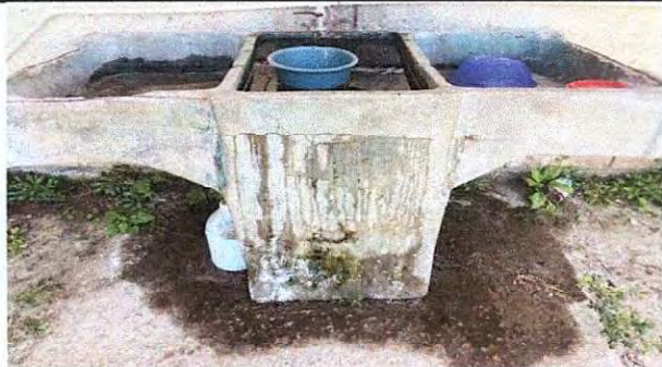
Foto 13: Sustrucción de pila de dos lavaderos
