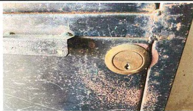
Foto 4: sustitución de chapa
