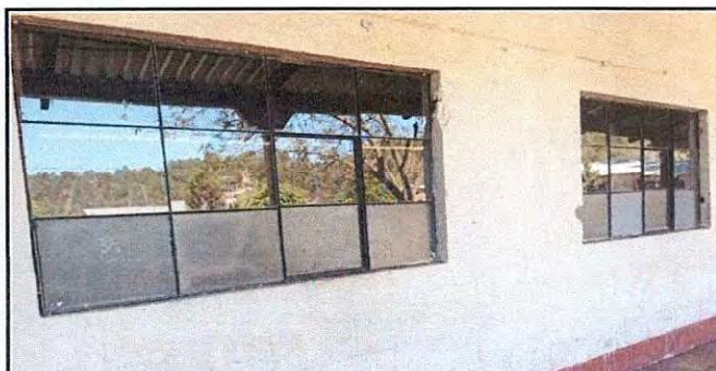
Foto15: Fabricación e instalación de ventana-balcon de metal
