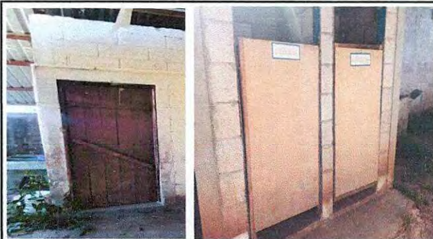
Foto 6: sustitución de puerta madera a metal
