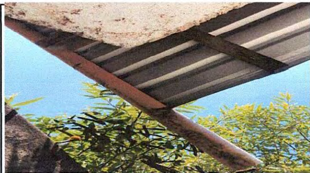
Foto 9: Sustitución de canal pvc
