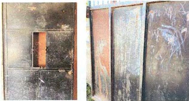
Foto 3: mantenimiento de estructura
