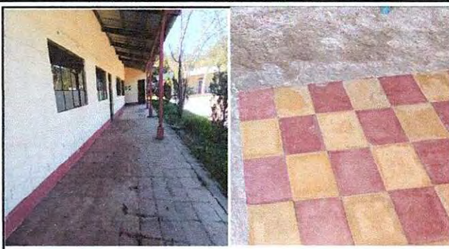
Foto 8: sustitución de piso de granito.
