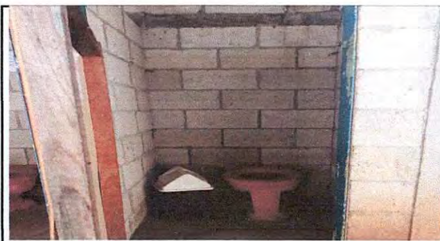
Foto 11: Sustitución de inodoro
