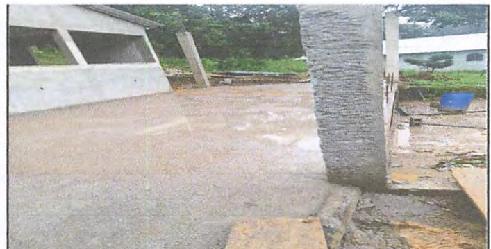
Foto 6: TORTA DE CONCRETO
