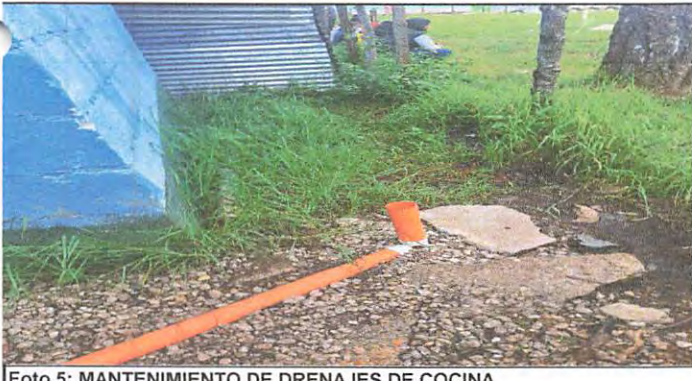
Foto 5: MANTENIMIENTO DE DRENAJES DE COCINA
