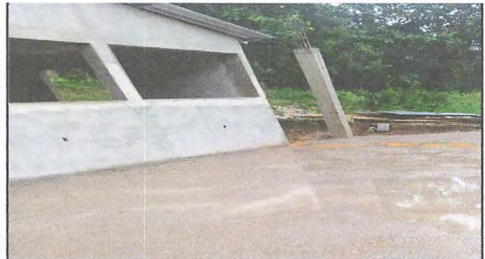
Foto 4: PARED DE REFUERZO EN TORTA DE CONCRETO
