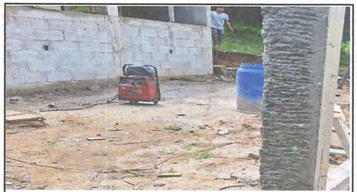
Foto 4: PARED DE REFUERZO EN TORTA DE CONCRETO
