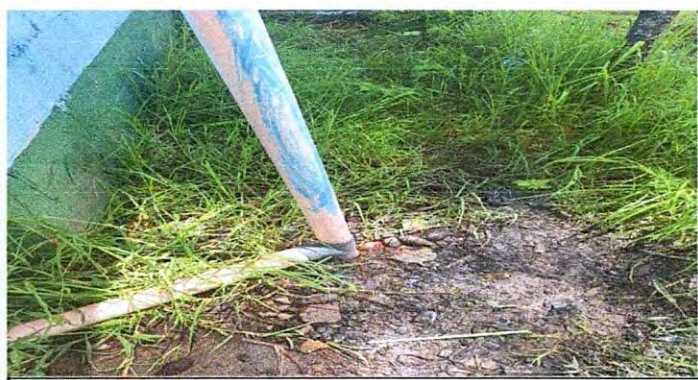
Foto 5: MANTENIMIENTO DE DRENAJES DE COCINA
