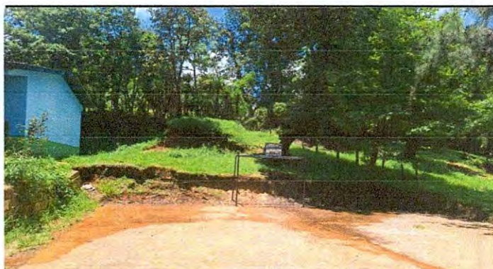
Foto: PARED DE REFUERZO EN TORTA DE CONCRETO
