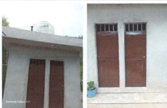
Foto 2: Se observa ambos sanitarios ya finalizados y colocación de tinaco.
