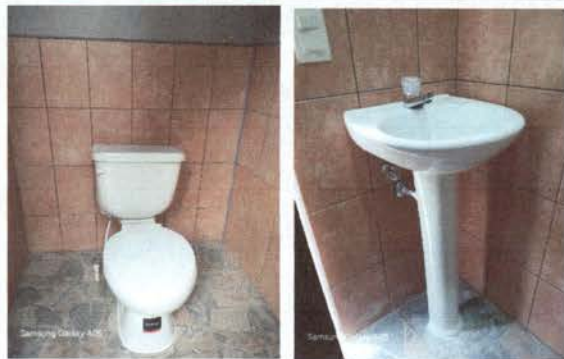
Foto1: Se observa la finalización de trabajos en sanitarios.
