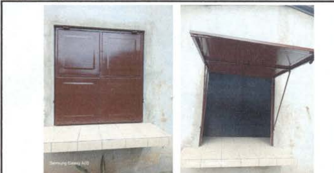
Foto 5: Se observa la finalización de ventana tipo caseta y sillar para despachar alimentos.
