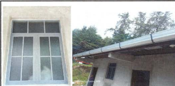
Foto 2: Se observa la finalización de ventana en bodega y canal en bodega y cocina.
