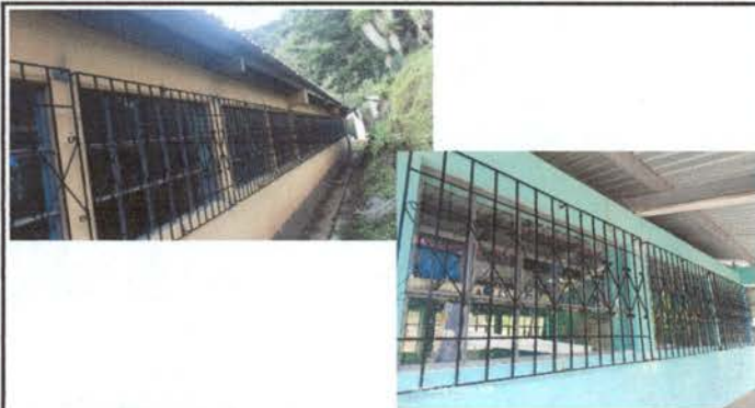
Foto1: Se observa la finalización de balcones en ambos lados de tres aulas con los respectivos vidrios colocados.
