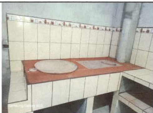
Foto 3: Finalización de los trabajos de estufa rural.
