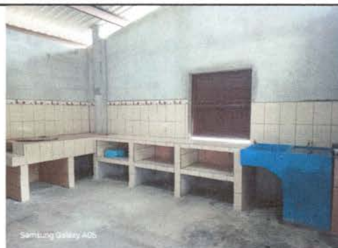
Foto 4: Finalización de trabajos de desayunoador y gabinetes en cocina y colocación de pila.
