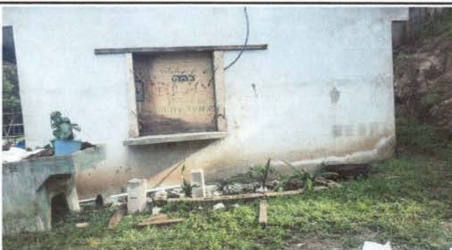
Foto 5: Se observa la perforación de la ventana tipo caseta para la cocina.
