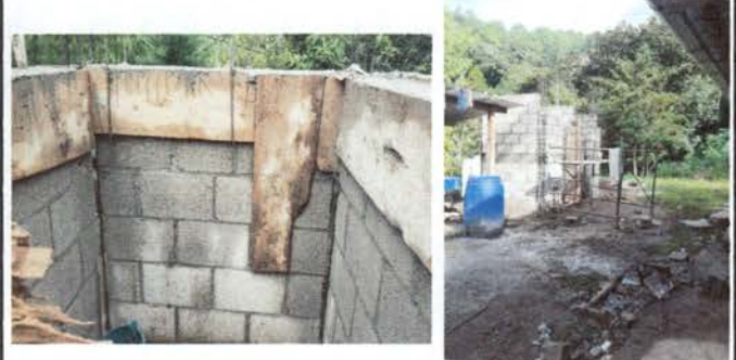
Foto 2: Se observa el avance de los trabajos en ambos sanitarios-
