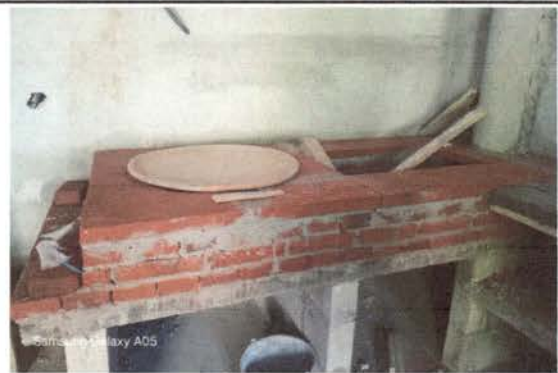
Foto 4: Se observa el avance del trabajo del poyo de la cocina.
