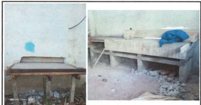
Foto 6: Se observa la fundición de pestaña para servir alimentos y el avance de gabinetes y desayunoador en cocina.
