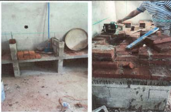
Foto 3: Se observa el inicio de trabajo del poyo de la cocina.
