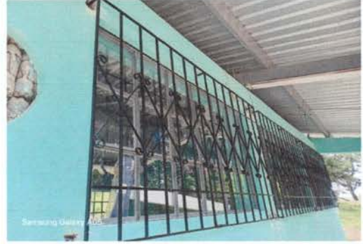
Foto 2: Se observa el avance de la colocación de balcones en aulas.
