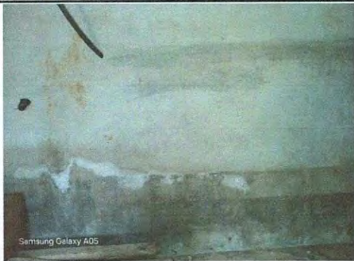
Foto 3: Se observa el espacio donde se construirá el poyo de la cocina
