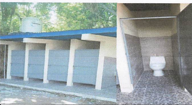
Foto 5: pintado de pared de sanitarios.
