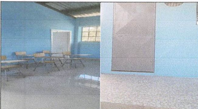
Foto 3: colocación de piso porcelanato dentro del salón y antideslizante en el corredor.
