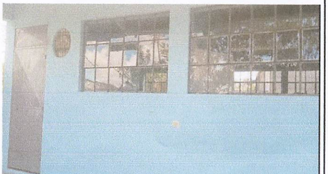
Foto 4: pintura de paredes del establecimiento.
