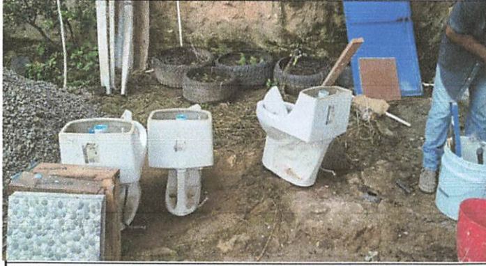
Foto 1: Lijado y pintura de puertas de sanitarios, colocacion de piso antideslizante y azulejo
