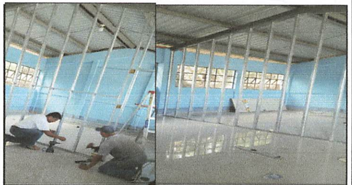
Foto 6: sustitución de divisiones de salones
