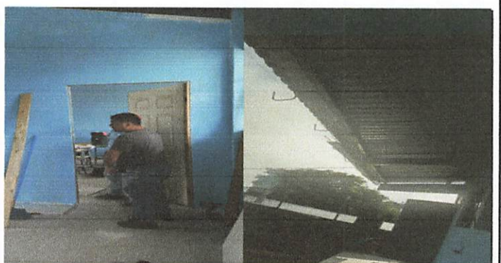
Foto 6: sustitución de divisiones de salones
