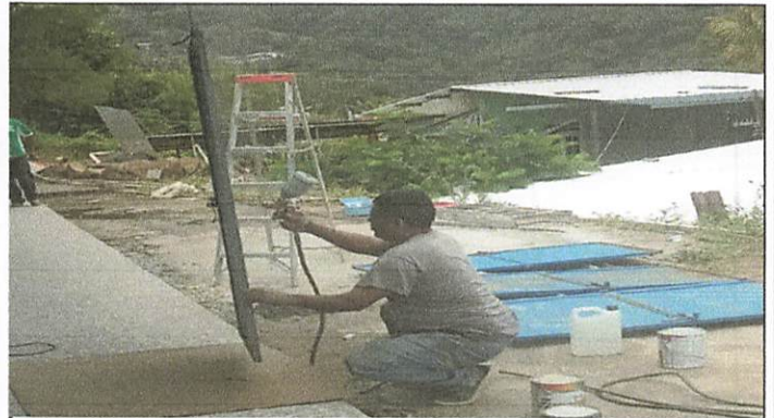
Foto 2: Lijado y pintura de puertas de sanitarios, colocación de piso antideslizante y azulejo
