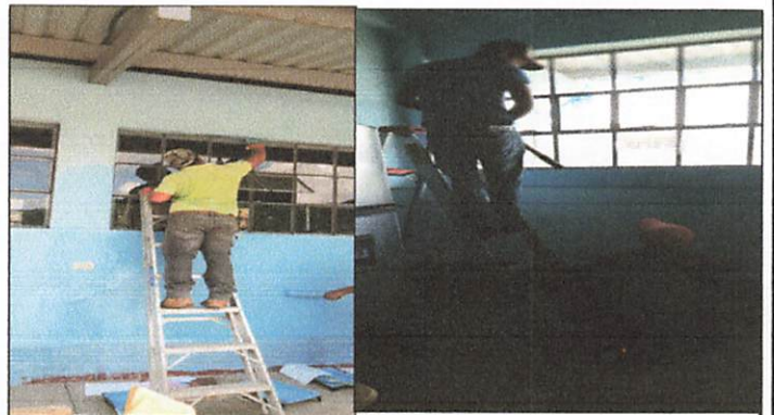
Foto 4: pintura de paredes del establecimiento
