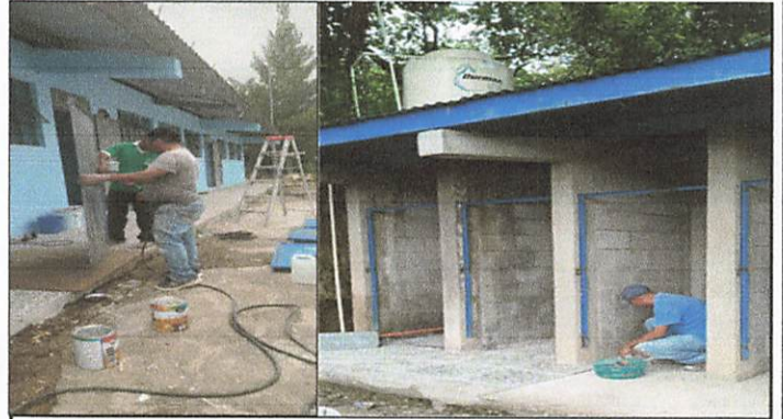
Foto 2: Lijado y pintura de puertas de sanitarios, colocacion de piso antideslizante y azulejo
