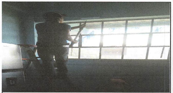
Foto 4: pintura de paredes del establecimiento
