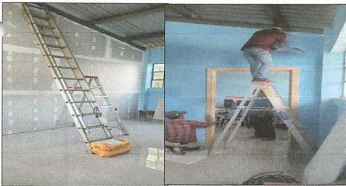
Foto 5: sustitución de divisiones de salones
