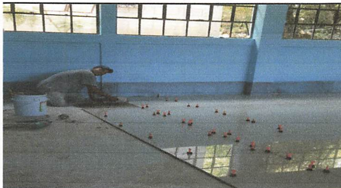
Colocación de piso porcelanato dentro del salón y antideslizante en el corredor
