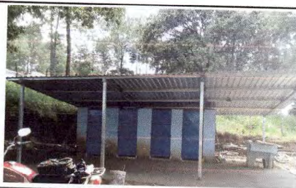
Foto 6: Banqueta de concreto de sanitarios.
