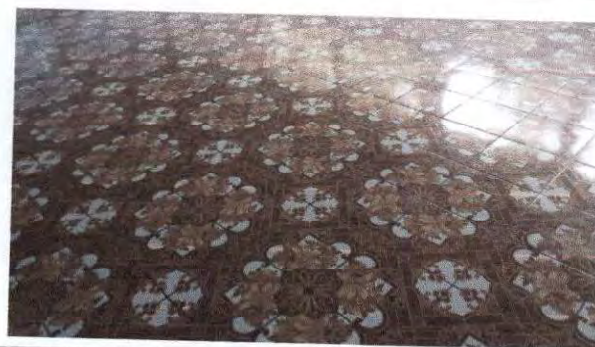
Foto 6: Piso cerámico en bodega.
