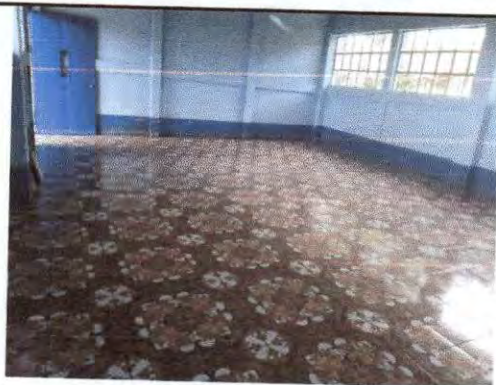
Foto 3: Instalación de piso Cerámico en aulas.
