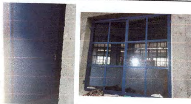
Foto 6: Puertas y Ventanas de cocina
