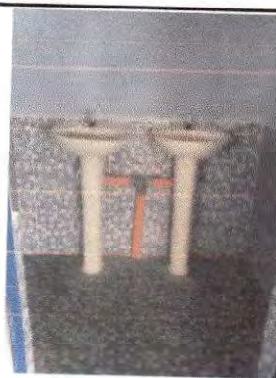
Foto 4: Desmontaje e instalación de lavamanos
