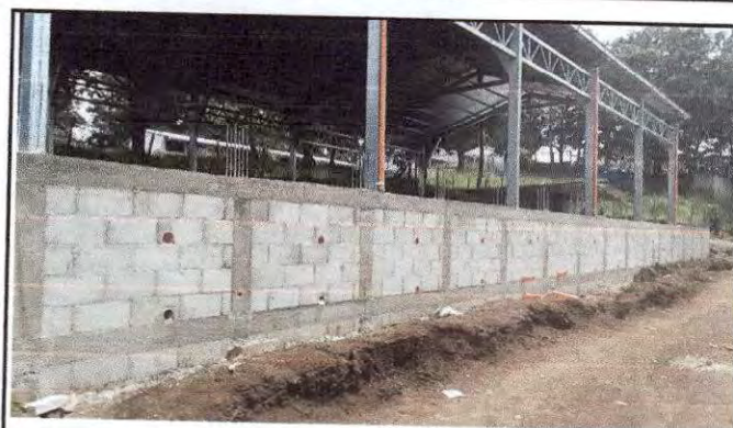
Foto 4: Muro de contención
