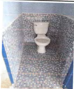
Foto 3: Piso cerámico y azulejo de sanitario
