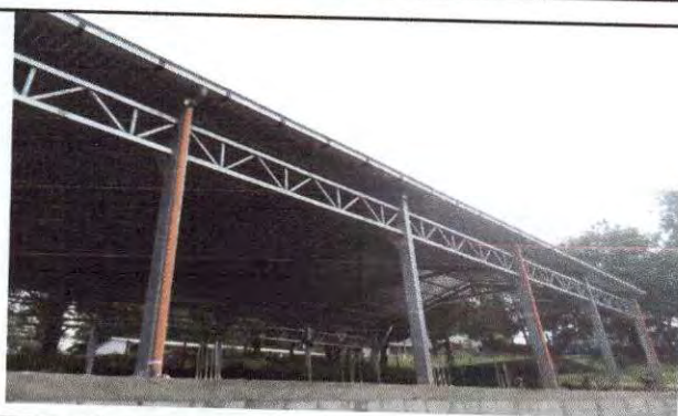
Foto 5: Canales, pescantes y bajadas pluviales.
