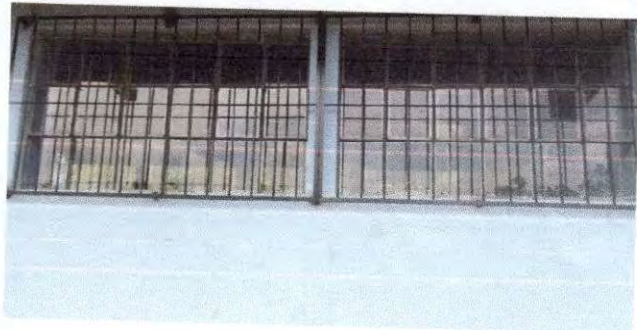
Foto: Sustitución de vidrios
