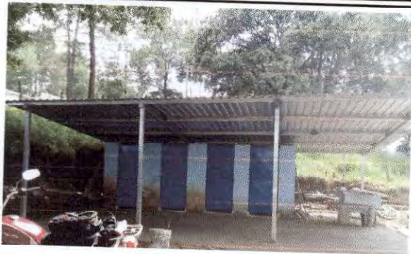
Foto 1: Estructura de techo de sanitario
