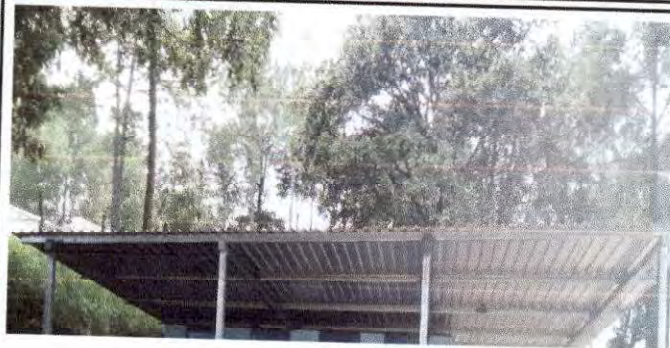
Foto 2: Cubierta de lámina de Sanitario
