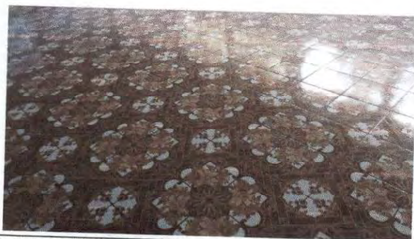
Foto 5: Piso cerámico de cocina.
