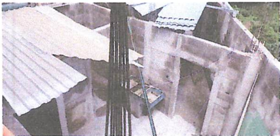
foto: 1 construcción de cajón de cocina ya que solo esto alcanzó con los 75,000 del programa de remozamiento
