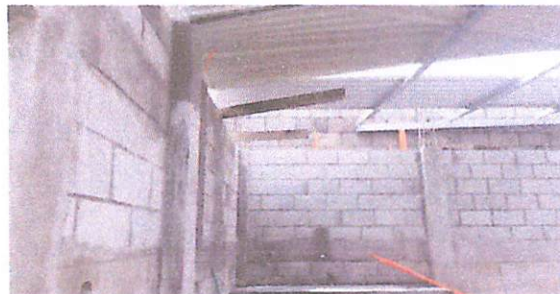
foto: 2 construcción de cajón de cocina ya que solo esto alcanzó con los 75,000 del programa de remozamiento
