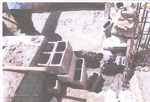
foto 4 fundición de columnas
