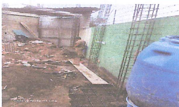
foto 3 fundición de zapatas
