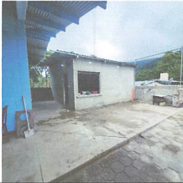
Foto 1: Levantado de pared terminado
