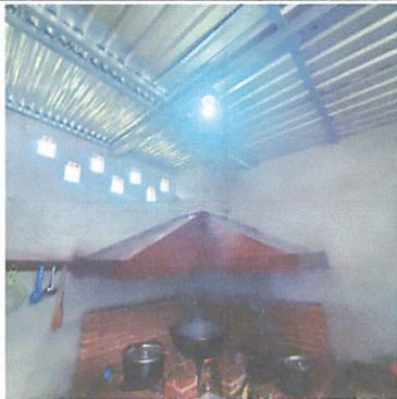
Foto 3: Instalación de techo
