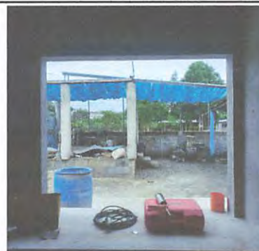
Foto 8: Instalación de drenaje.
