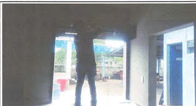
Foto 15: Instalación de perciana.
