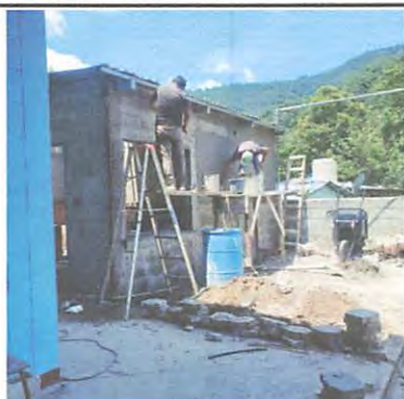
Foto 9: Instalación de drenaje.
