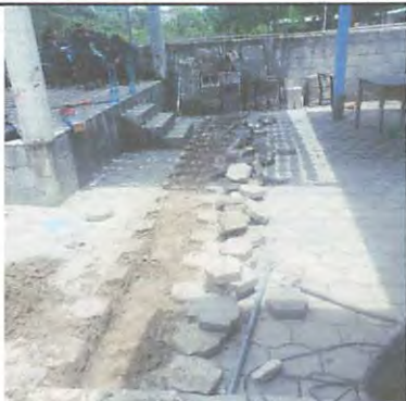
Foto 7: Instalación de drenaje.
