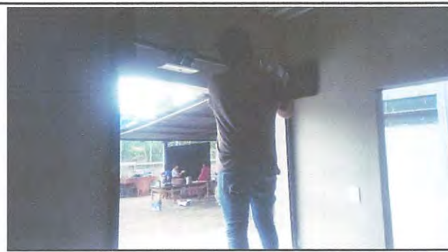
Foto 16: Instalación de perciana.
