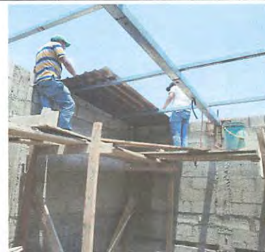
Foto 2: Instalación de techo.
