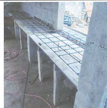
Foto 4: Construcción de mesa de concreto.
