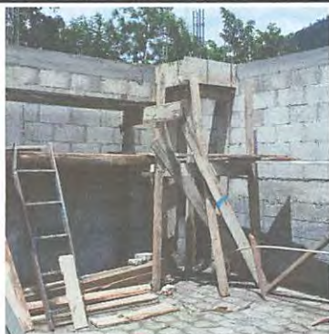
Foto 21: Levantado de pared.
