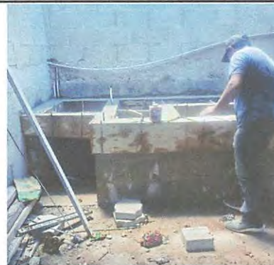
Foto 14: Instalación de pila.
