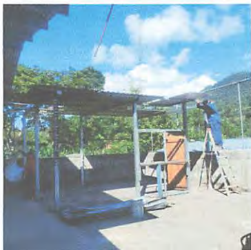
Foto 1: Instalación de techo
