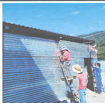
Foto 6: Remplazo de puerta.
