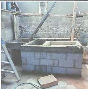
Foto 13: Construcción de pila.
