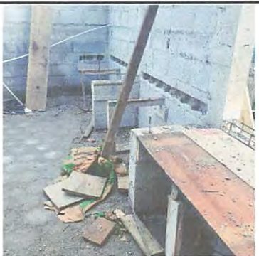
Foto 5: Construcción mesa de concreto.
