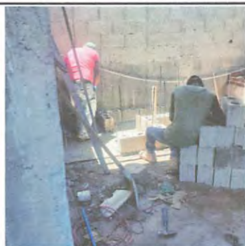
Foto 11: Construcción de Pila
