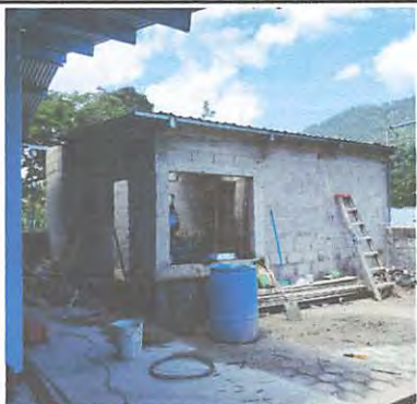
Foto 3: Instalación de techo.
