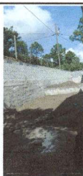
Foto 3: Finalización de la circulación de pared de block con malla.
