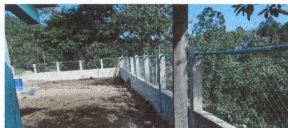
Foto 2: Finalización de la circulación de pared de block con malla.
