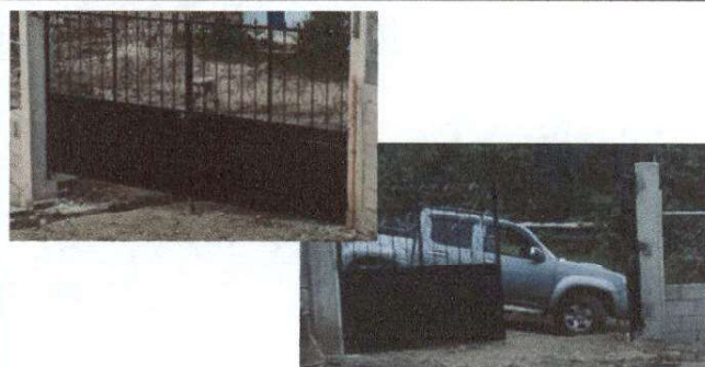
Foto 5: Finalización del portón.
