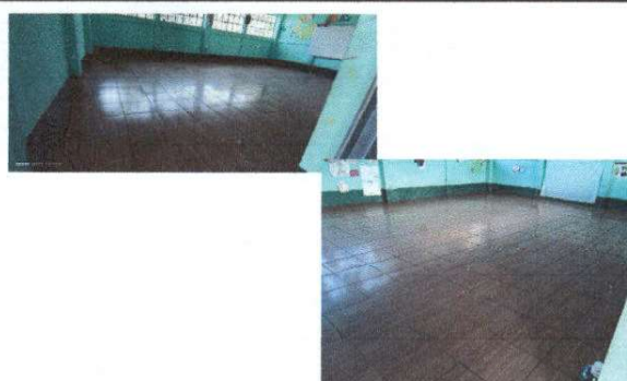
Foto 6: Finalización del cambio de piso cerámico.
