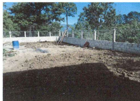
Foto 4: Finalización de la circulación de pared de block con malla.
