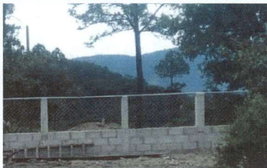
Foto 1: Finalización de la circulación de pared de block con malla.
